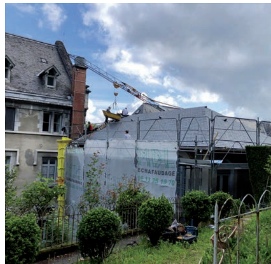
Travaux Maison des Chapelains
