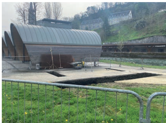
Travaux Chapelle des Lumières
