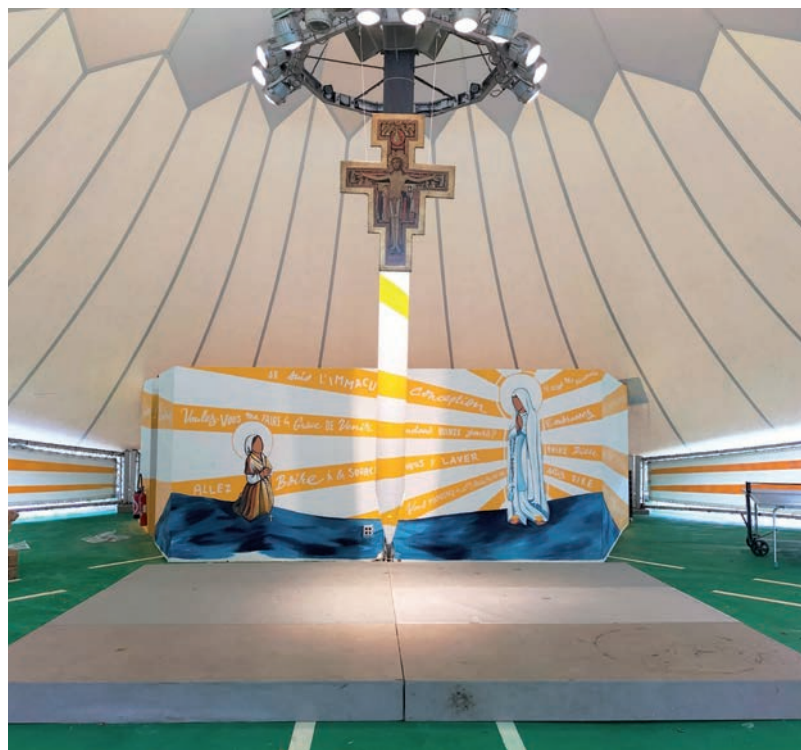
Travaux Tente des Jeunes
